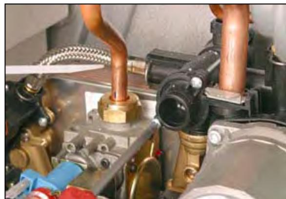
3. Сняв суппорт привода, можно вынуть затвор трехходового клапана;
