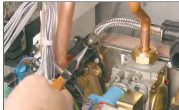
2. Снять трубку байпаса и выкрутить 2 винта «А» и «В», которые крепят вторичный теплообменник к узлам подачи и возврата;
