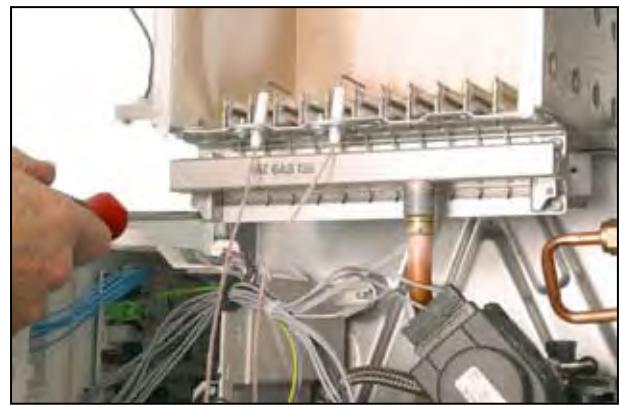
5. Отсоединить газовый коллектор от горелки;
