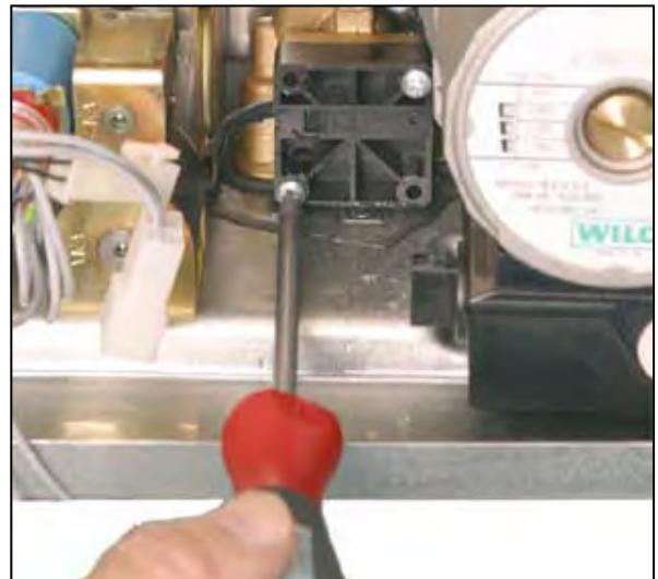
2. Снять датчик протока ГВС и отсоединить разъем провода датчика.
