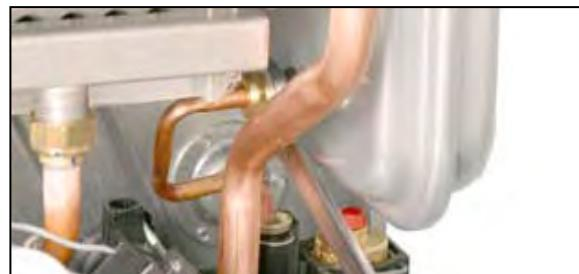
2. Выкрутить винт крепления расширительного бака к шасси котла;
