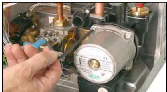
3. Вынуть двигатель и крыльчатку насоса.
