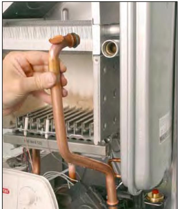
5. Аналогично тому, как описано в пункте 1, отсоединить датчик температуры от трубы подачи нагрева. Аналогично тому, как описано в пункте 2, снять фиксатор трубы подачи к теплообменнику;
