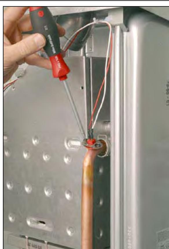
2. С помощью плоскогубцев снять фиксатор трубы возврата;
