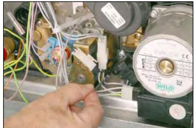
4. Открутить 4 винта, фиксирующие газовый коллектор к горелке;
