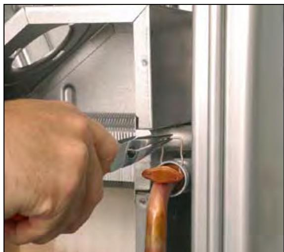
3. Отсоединить фиксатор трубы возврата от насоса;
